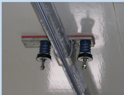
Neue, Befestigung der Kranbahnschiene an der Decke mit HBT-ISOL Kranbahnlagersystem
