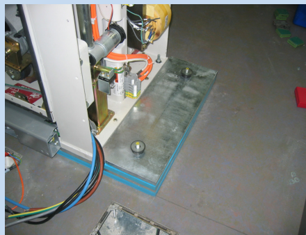
Gelagertes CT-Gerät nach dem Einbau des Sicherungssystems
