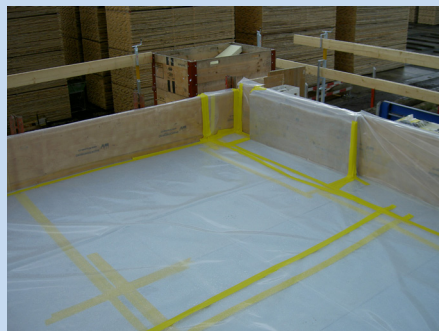
Fertige Lagerung, zum Betonieren bereit
