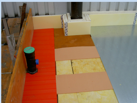
Flächenlagerung mit ISOLMER, Stahlblech und Randstellstreifen
