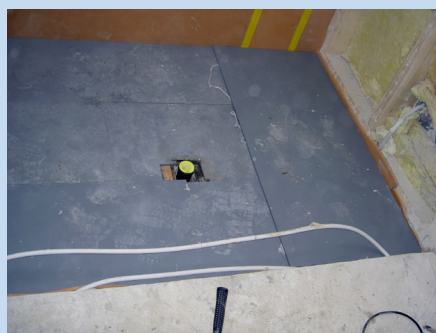
Verlegte Stahlplatten in Teilstücken
