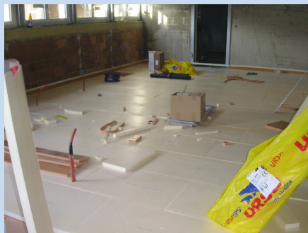
Lagerung mit Durchdringungen und Wärmedämmung
