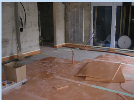
Lagerung und Entkopplung Metzgerei mit Kanälen
