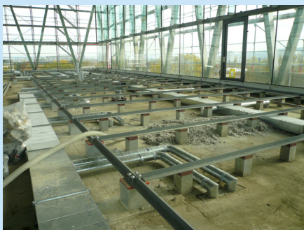
Stahlkonstruktion auf schalldämmten Betonklötzen und Erdbebensicherung
