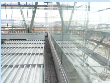
Trapezbleche als verlorene Schalung auf der Stahlkonstruktion
