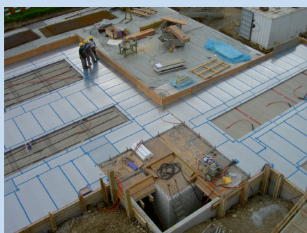
Qualitätskontrolle nach erfolgter Montage
