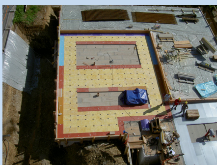
Verlegte Punkt-Streifenlagerung Etappe 2
