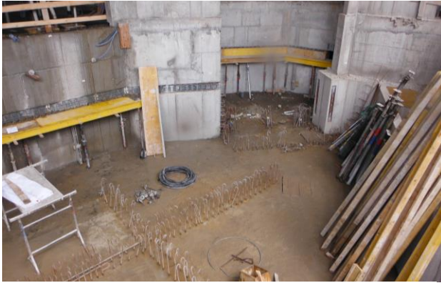
Blick in die Rohbauphase für den grössten Pool des Schwimmbereichs
