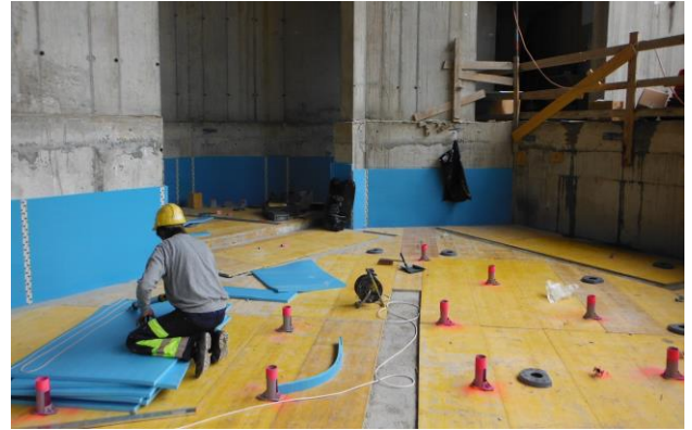
Beginn der Lagerung des Schwimmbeckens mittels ISOLMER® Polyurethan Schaumplatten durch qualifiziertes Personal der HBT-ISOL
