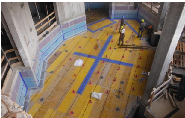
Grosses Schwimmbecken mit ISOLMER® gelagerten Wände, bereit zum bewehren.
