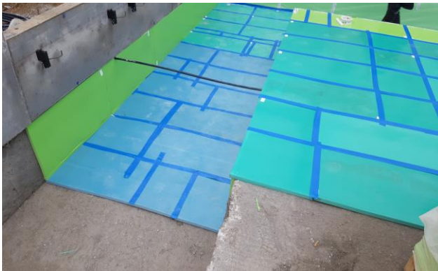
Montage der auf die Lasten dimensionierten horizontalen und vertikalen Lagerkomponenten im Bereich der Vertiefungen für die Liftunterfahrten und der Stützen-Fundamente.
