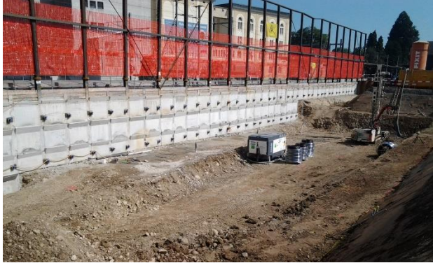
Bausituation mit dem Aushub und der Bahnlinie im Hintergrund. Die Gebäude werden entlang der Bahnlinie mit einer dauerelastischen Lagerung aus Polyurethanschaum-Platten schwingungsfrei vom Erdreich getrennt.
