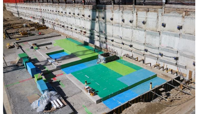
Montage der ersten Flächen der präzise auf die Lasten abgestimmten Gebäudelagerung. Diese Trennung zum Erdreich verhindert, dass die vom Bahnverkehr verursachten Schwingungen und Erschütterungen direkt in das Gebäude eingeleitet werden.
