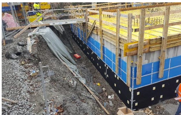
Aufbau der vertikalen Lagerung unmittelbar vor der Hinterfüllung zur Stabilisierung der Lagerung
