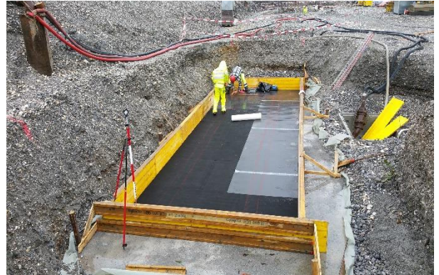
Montage der ersten Flächen der präzise auf die Lasten abgestimmten Gebäudelagerung. Diese Trennung zum Erdreich verhindert, dass die vom Bahnverkehr verursachten Schwingungen und Erschütterungen direkt in das Gebäude eingeleitet werden.
