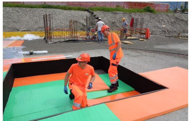
Bei der Ausführung gilt es durch exaktes Arbeiten jede mögliche Körperschallbrücke zu verhindern – nur so bringt die Lagerung ihre volle Dämmleistung. Das Bild oben zeigt die Montageequipe der HBT-ISOL bei der Lagerung einer Vertiefung
