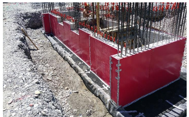
Exakt ausgelegte und montierte Vertiefung, als späteres Liftfundament
