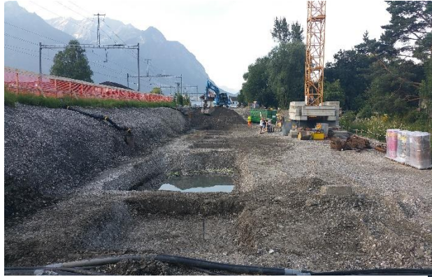
Bausituation mit Aushub in direkter Nähe zur Bahnlinie. Die Gebäude werden entlang der Bahnlinie mit einer dauerelastischen Lagerung aus Polyurethanschaum-Platten schwingungsfrei vom Erdreich getrennt.
