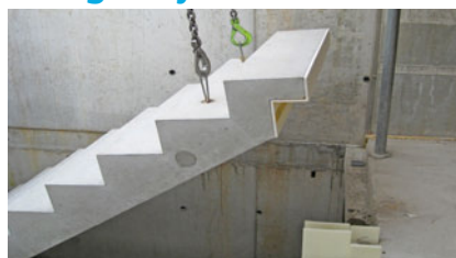
Versetzen der Treppe mit aufgeklebtem Treppenlager ISOTREPP. Das Treppenlager ISOTREPP ist massgenau auf die Abwicklung des Laufes gefertigt.
