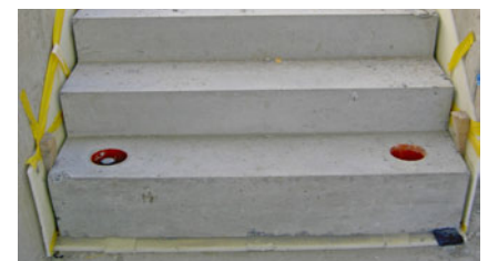
Versetztes Treppen-Element mit seitlicher ISOPE-Trennung zum Gebäude. Im Vordergrund die Rohreinlagen zur Montage der körperschalldämmenden Sicherungsdorne ISODORN.
