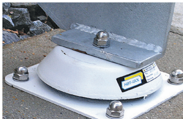
Eingebautes Treppenlager ISOTRELA. Einfach und fehlerfrei montiert mit Schraub-Verbindungen.
