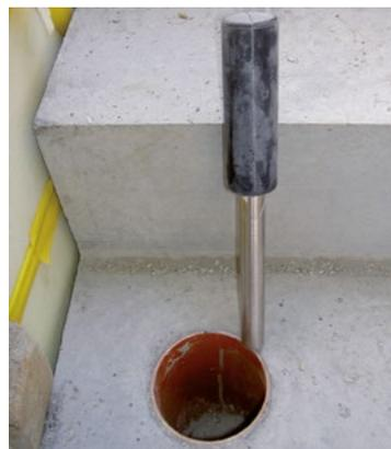
Der körperschalldämmende Sicherungsdorn ISODORN wird durch die Rohr-Aussparung in das Bohrloch in der Decke eingeführt. Danach wird die Aussparung mit Vergussmörtel geschlossen.
