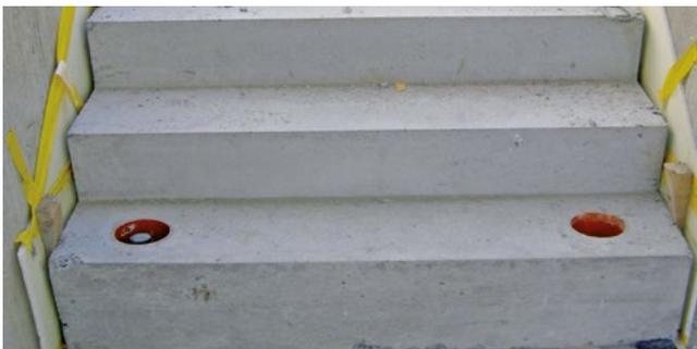
Versetztes Treppen-Element mit seitlicher ISOPE-Trennung zum Gebäude. Im Vordergrund die Rohreinlagen zur Montage der körperschalldämmenden Sicherungsdorne ISODORN.
