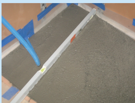
Abtalschieren der betonierten Lastverteilerplatte.
