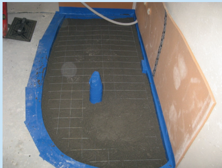
Die Lastverteillatte ist betoniert, der Whirlpool kann platziert werden.
