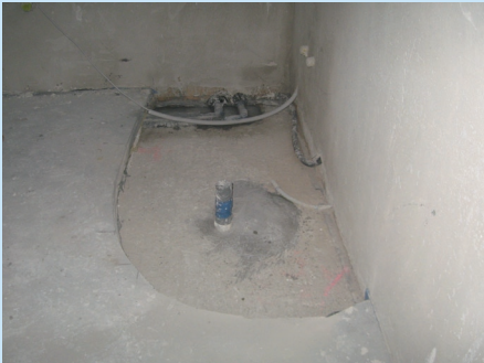
Aussparung bereit für das Verlegen des Lagers.
