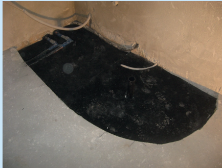
Verlegen des Bodenlagers.
