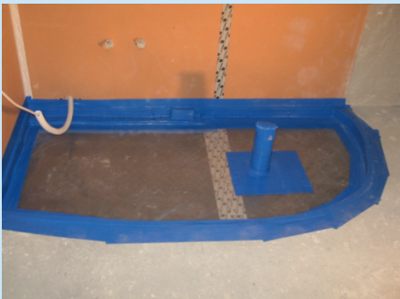
Die fertige Lagerung, bereit zum Betonieren der Lastverteillatte.
