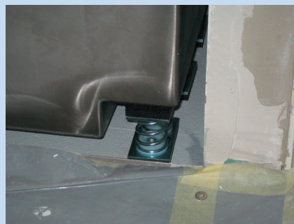
ISOLASTIC-Stahlfederpakete zur Dämmung der tieffrequenten Vibrationen
