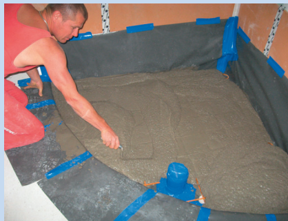
Die Lastverteilplatte wird betoniert
