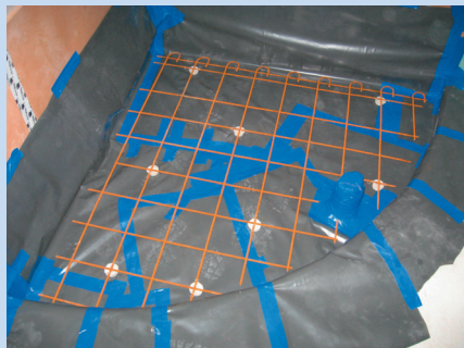
Lagerung mit PE-Folie und Armierungsnetz, bereit zum Betonieren
