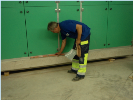
Genauere Prüfung der waagrechten Lagen.
