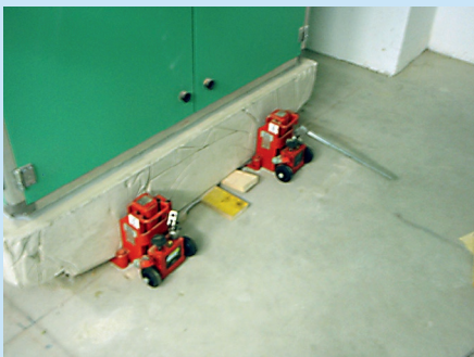
Die Betonsockel mit den Maschinen werden angehoben.
