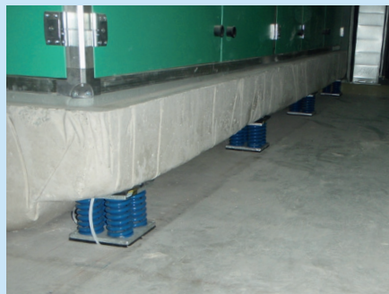
Die Stahlfederpakete sind platziert.
