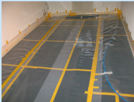
Bereit für den Einbau des Unterlagsbodens.
