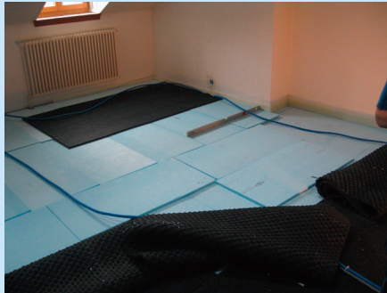
Schiften der Trag-Unterkonstruktion.
