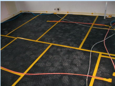
Verlegen des Schalldämm-Materials.
