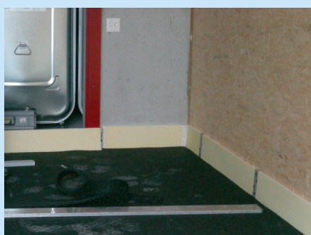
Abkoppelung der Wände durch Randstell- streifen. Verlegen der Schalldämm-Matten.
