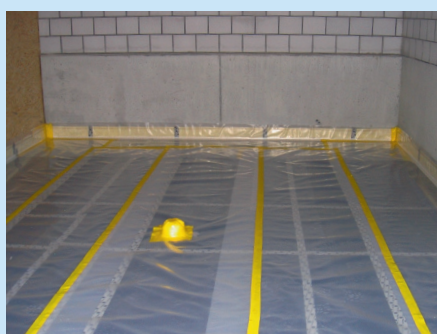
Bereit zum Bewehren und Betonieren.
