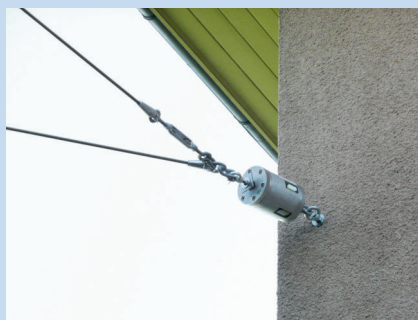
ISOTROLLY an der Fassade montiert
